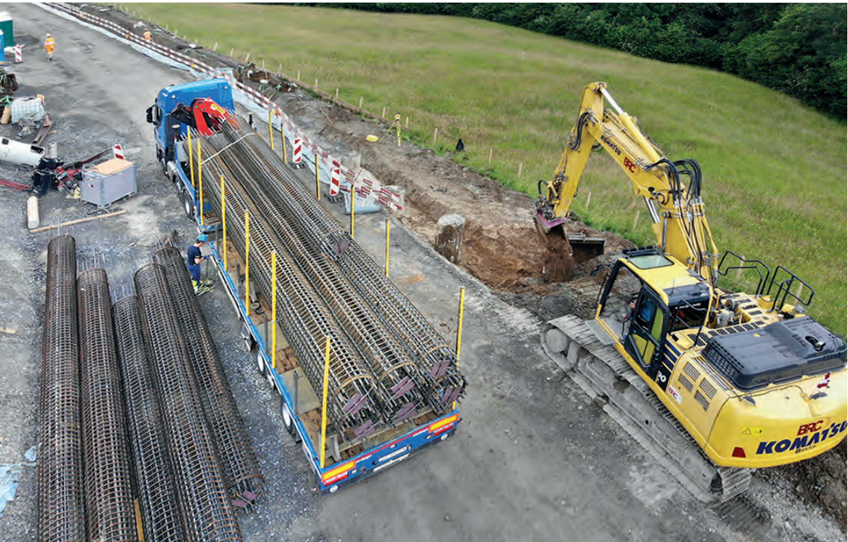
Anlieferung Bohrfpahlbewehrung
