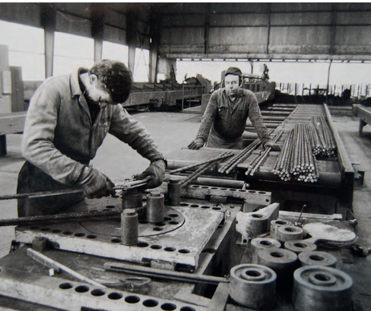
Historisch verbürgte manuelle Montage von Bewehrungsstahlelementen
