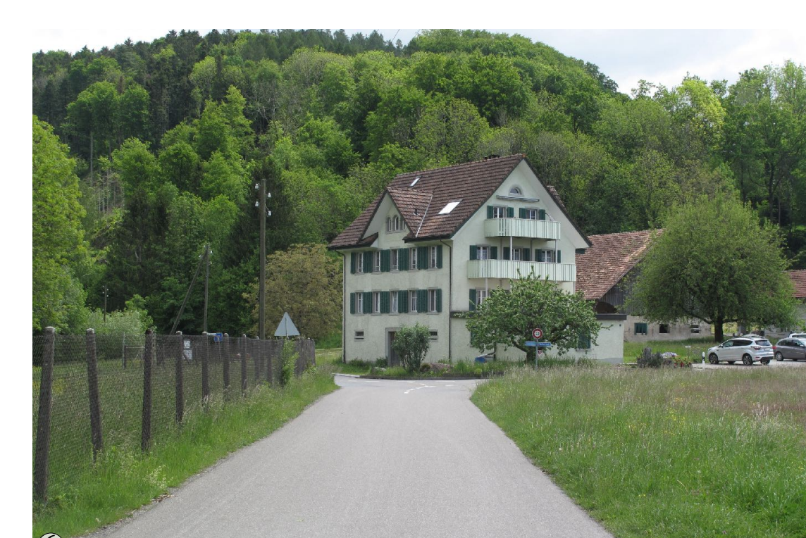
Das historische und schützenswerte Gebäude an der Wegvergabe kann als wichtiger Orientierungspunkt entlang der Seestrasse im Dorf Nuolen dienen.
