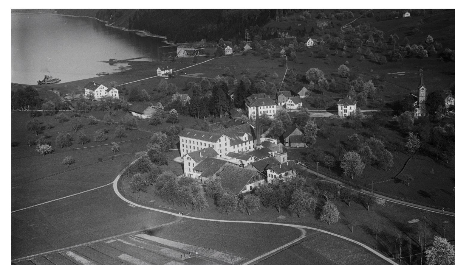
Die historische Luftaufnahme von 1926 zeigt die noch unbefestigte Seestrasse mit den heute mehrheitlich als schützenswert eingestufte Bauten. Im Vordergrund die unterdessen abgebrochenen Spinnerer-Bauten.
