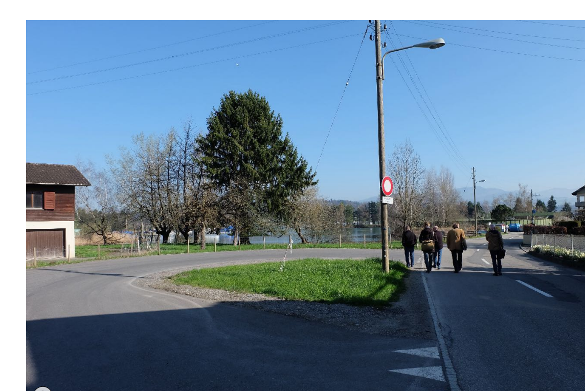
Im Abschnitt ab der Bruggholzstrasse fehlt entlang der Seestrasse eine Infrastruktur für den Fussverkehr. Lediglich ein verbreiteter Bankett dient nordsüdlich der Seestrasse als Fussgängerschutz. In der linken Bildhälfte ist die Buswendemöglichkeit der Buslinie 522 ersichtlch.
