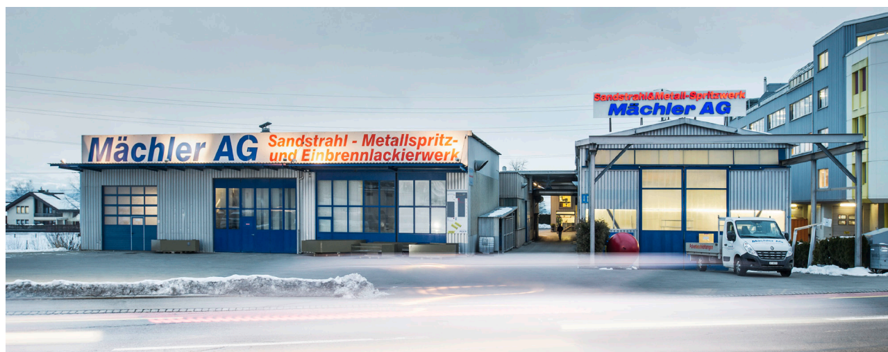
Aktuelle Aufnahme des Areal
